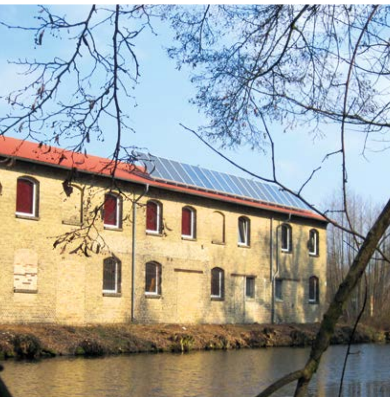
Abb. 6: Solarthermieanlage des Stahl Finow e. V.
