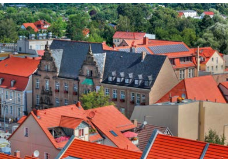
Abb. 12: Photovoltaik auf dem Rathausdach (Quelle: Robert Müller)
