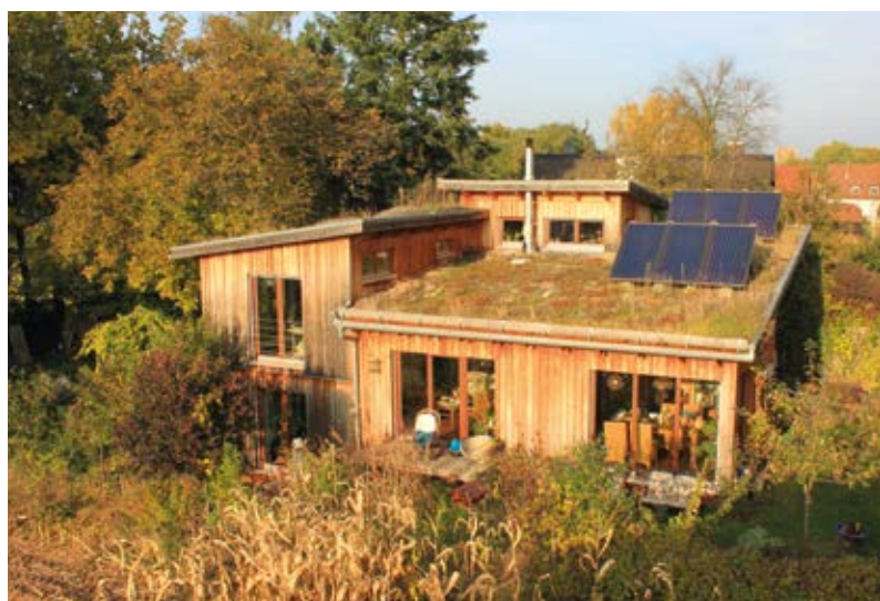
▲ Abb. 1: Holzhaus mit Gründach und Solarthermie (Quelle: Superikonoskop)
