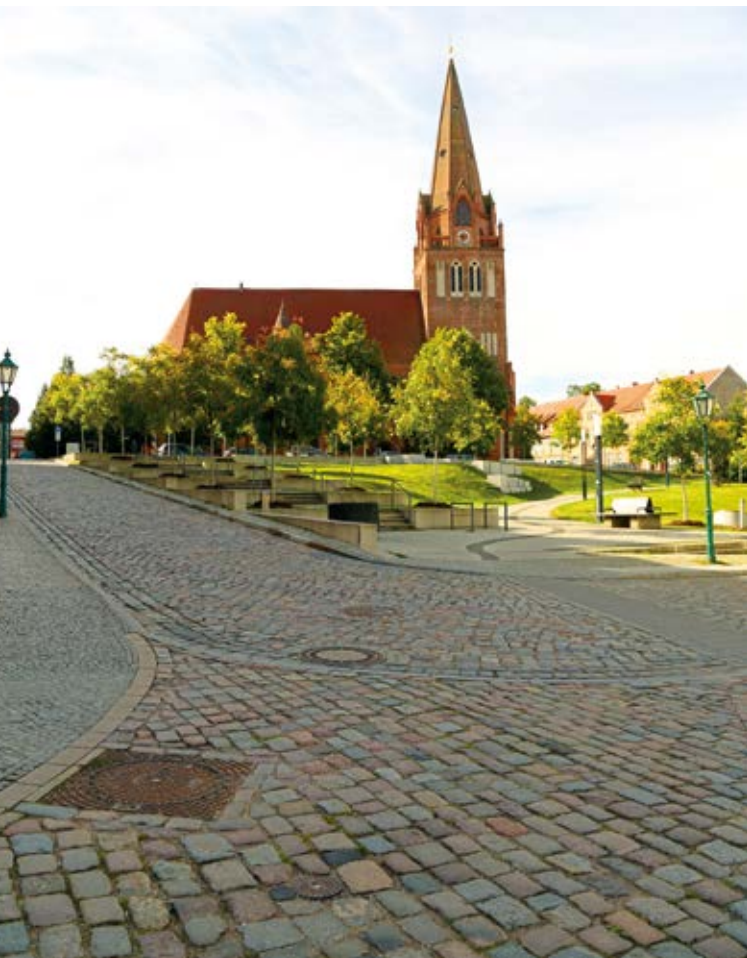
▲ Abb. 4: Natursteinpflaster im Altstadtbereich – attraktive Optik mit positivem Effekt für das Grundwasser
