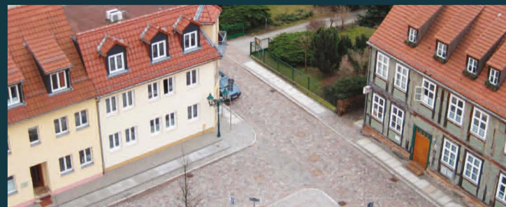
Alt und Neu ergänzen sich harmonisch am Kirchplatz.
