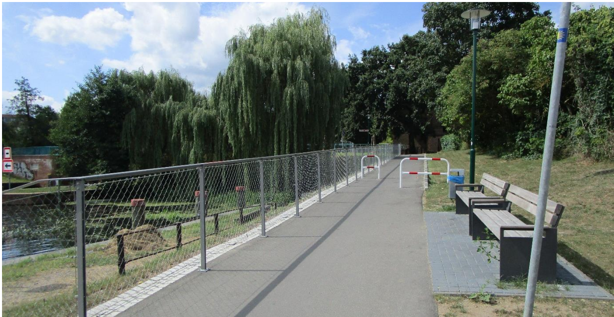
Abbildung 17 Neubau Rampe an der Stadtschleuse
