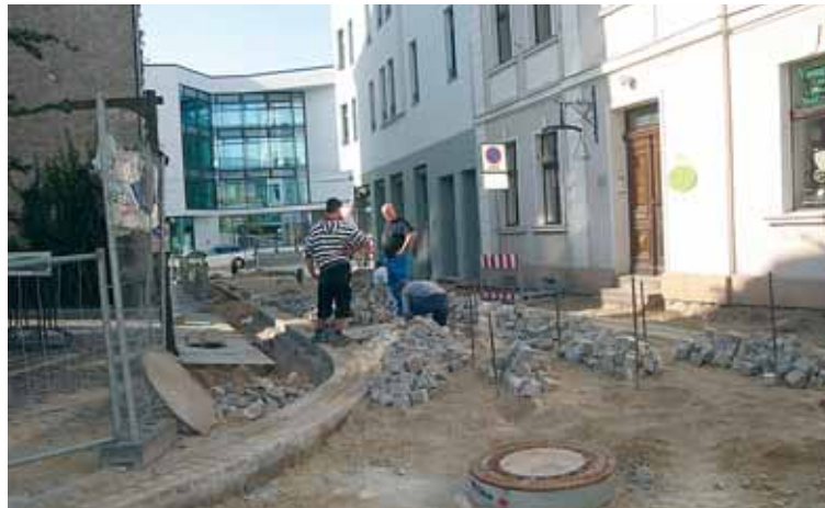
Bauarbeiten in der Kirchstraße im Jahr 2009.
