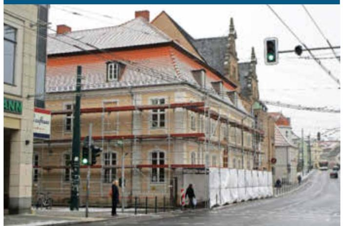
Die Sanierung des denkmalgeschützten „Alten Rathauses“ ist ein weiterer Bauabschnitt zum Ausbau des „Verwaltungsstandortes Mitte“. Seit Januar 2023 ist die Fassade des repräsentativen Eckgebäudes eingerüstet. Durch den Einbau eines zweiten Fahrstuhls wird der Gebäudekomplex barrierefrei nutzbar sein. Die Finanzierung wird anteilig mit Hilfe von Städtebaufördermitteln aus dem Programm „Wachstum und nachhaltige Erneuerung“ zu je einem Drittel von Bund, Land und Kommune abgesichert.
