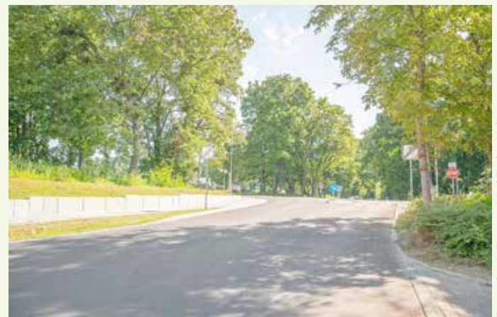
Im Bereich des Knotenpunkts mit der Freienwalder Straße wurde eine 3 Meter breite Mittelinsel zur Querung der Straße umgesetzt
