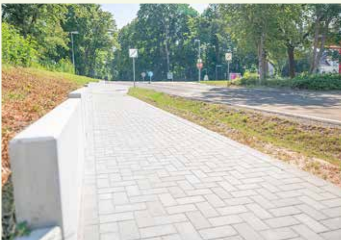
Der neue Gehweg mit einer Breite von 1,80 Metern aus Betonsteinpflaster
