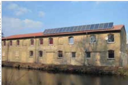
Solarthermie als Erneuerbare Wärmequelle auf dem Kanu-Stützpunkt vom SV Stahl Finow e.V.
