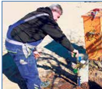
Herr Andreas Korn, Mitarbeiter der Fa. Perk, bei der Herstellung eines Bauwasseranschlusses
