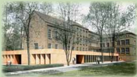
Blick in den Innenhof – im Anbau befindet sich die Kita
