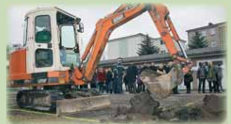
Offizieller Baubeginn - der erste Spatenstich erfolgte mit einem Bagger
