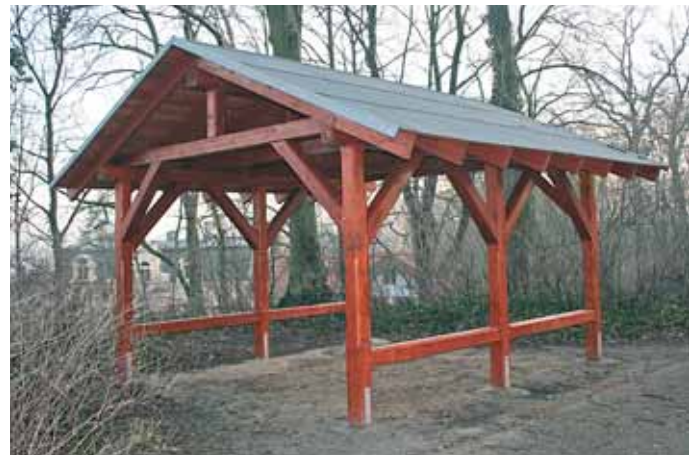
Seit Dezember 2011 steht der rote Holzpavillon am Schützenplatz. Foto: Blitz
