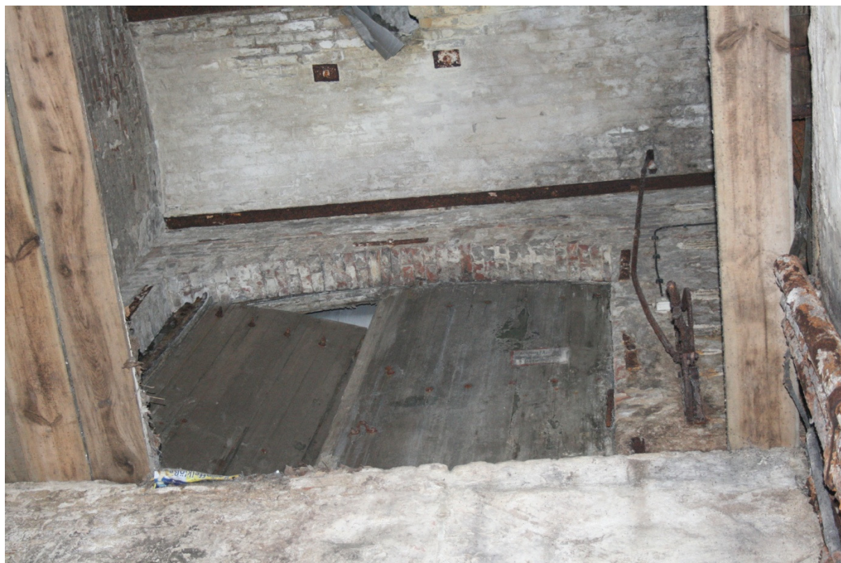
Abb. 2-2: Blick aus dem Keller zum Holztor des nach Westen exponierten Schachtausganges
