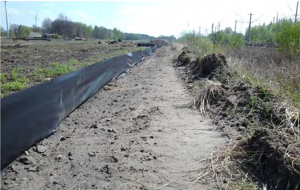
**Abbildung 3-3: Beräumter Korridor für den Kleintierzaun-Bau in einem PVA-Projekt an der ICE-Trasse Berlin - Hamburg bei Neustadt Dosse (LEGUAN GMBH 2013a)**
