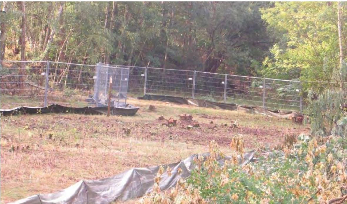
**Abbildung 3-2: Bauzaun als Schutz vor Beschädigung des Schutzzaunes auf einer einem Fußweg zugewandten Seite (LEGUAN GMBH 2016b)**
