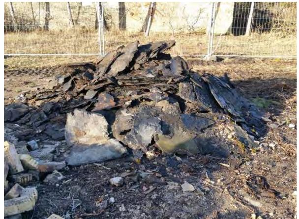
Bild 18: Ausgebauter und deklarerter Haufen mit teerhaltiger Dachpappe (12.02.2019)
