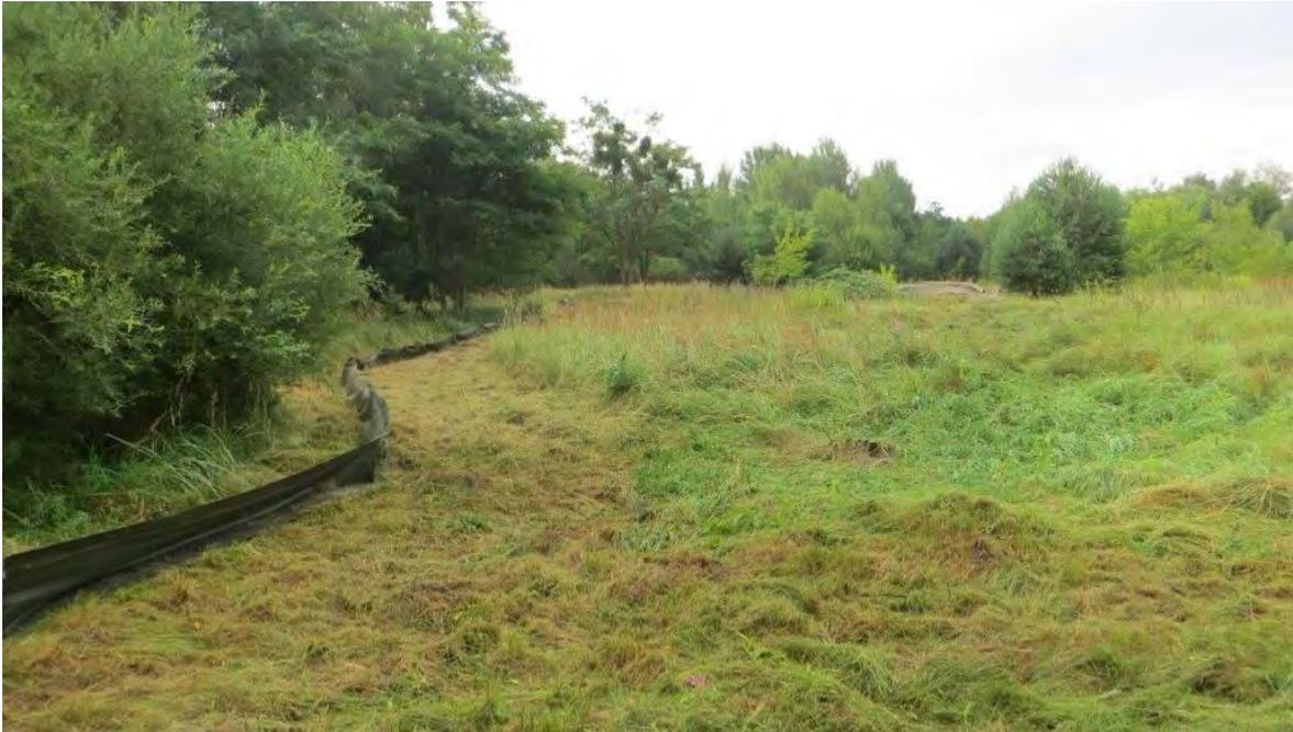
**Abbildung 3-4: gemähter Korridor in einem PVA-Projekt in Eberswalde (LEGUAN GMBH 2016b) nach Installation des Kleintierzauns**
