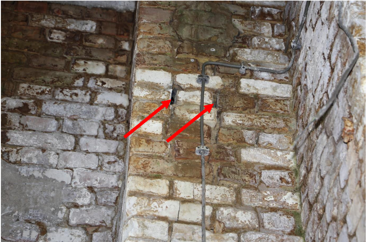
Abbildung 1: Quartierbereiche im Ziegelmauerwerk in o.g. Objekt 24/4.
