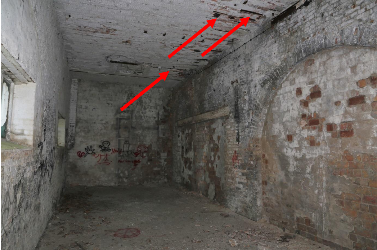
Abbildung 9: Objekt 24/4 Anbau an o.g. Werkhalle, Raum im Nordteil mit großem Ganzjahresquartier von Pipistrellus -Art (Zwerg-/ Mückenfledermaus).
