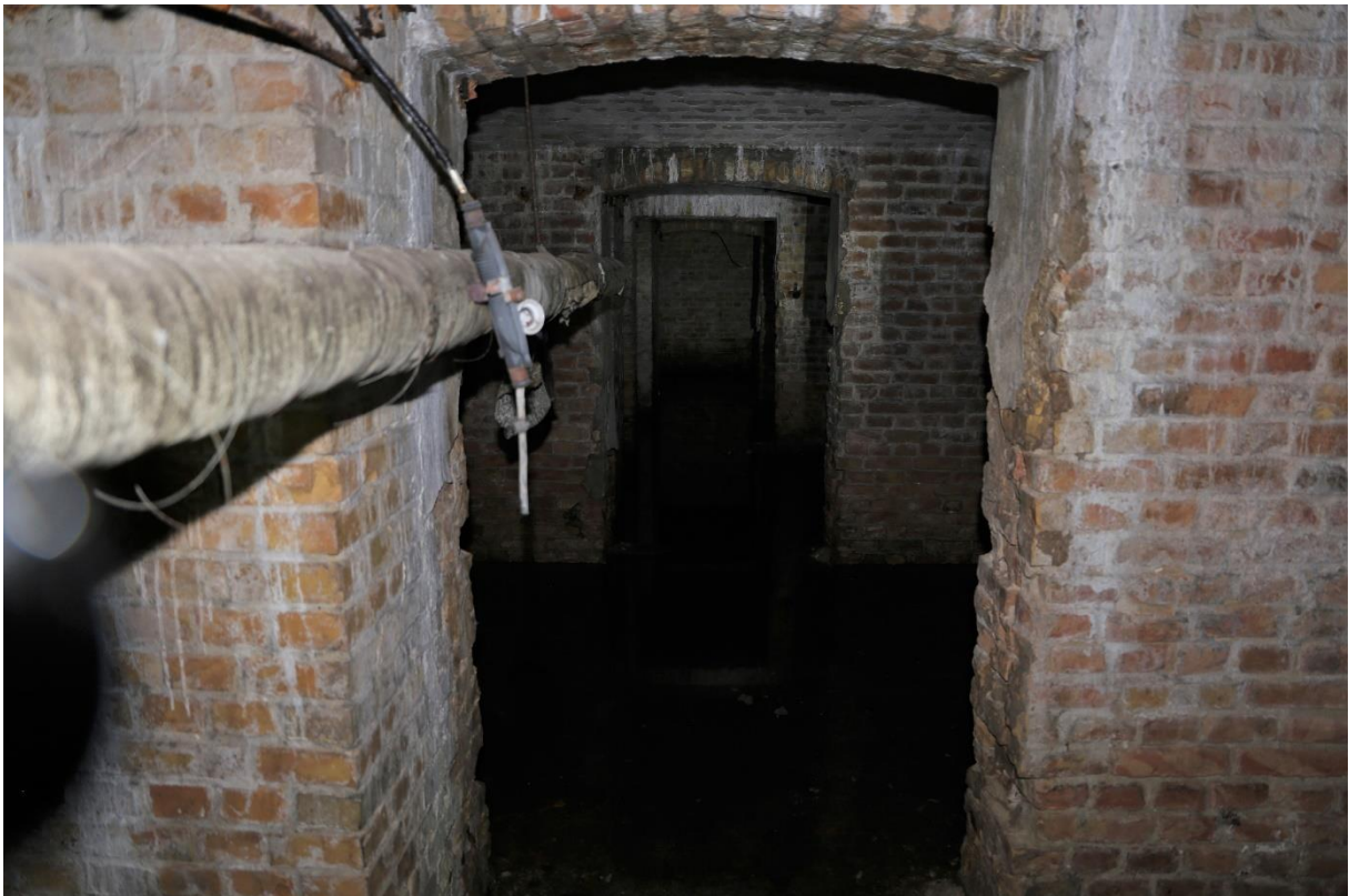
Abbildung 16: Großer Keller der Werkhalle 14, mit mehreren, miteinander verbundenen Räumen.
