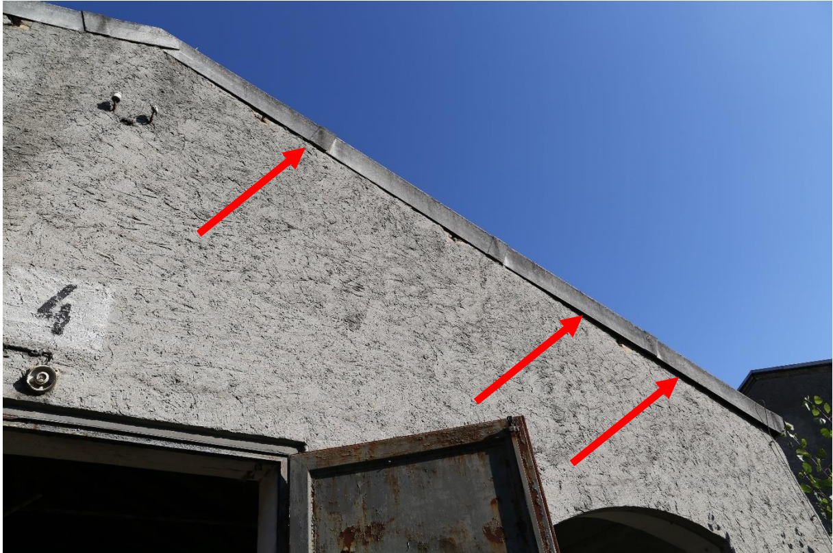
Abbildung 5: Potenzielle Quartierstrukturen unterhalb der Dachträufe (hier beispielhaft Objekt 5).
