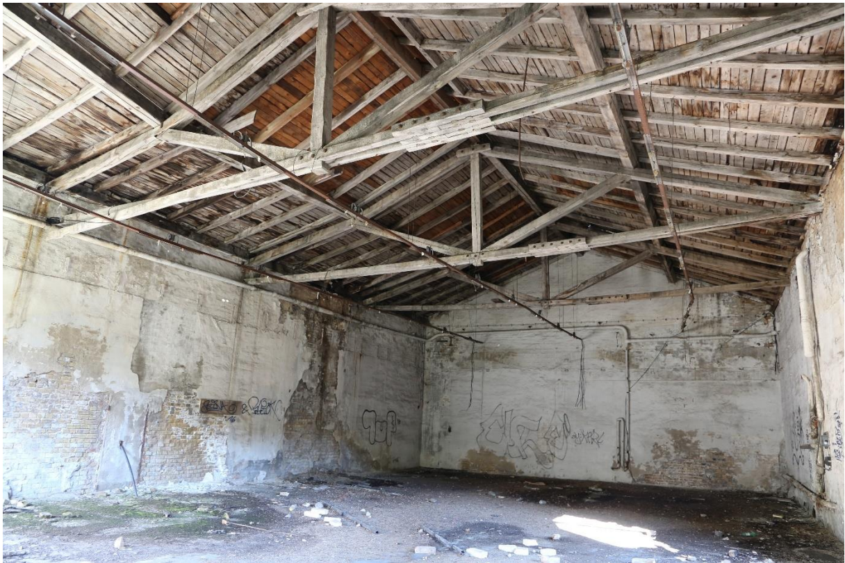
Abbildung 3: Dachkonstruktion der o.g. Werkhallen. Einfache Holzdeckung/ Teerdach.
