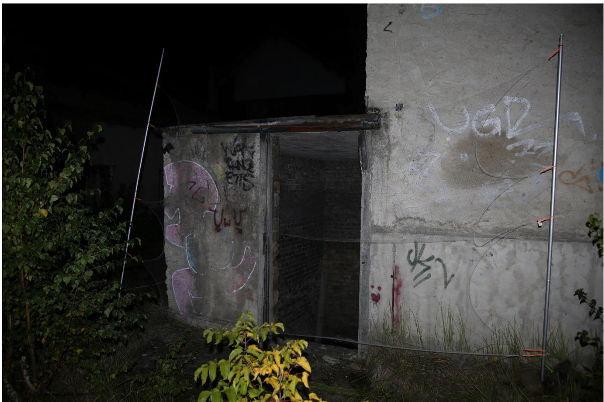
Abbildung 14: Netzfang vor Eingang in Keller des Objekts 14, Winterquartier feucht überwinternder Fledermausarten.
