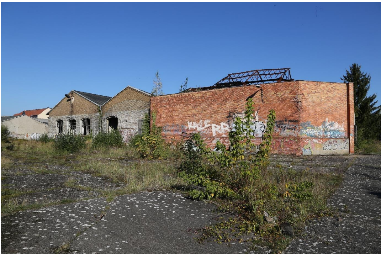
Abbildung 2: Zentraler Werkhallenkomplex, im Bild die Objekte 10, 11 u. 12.
