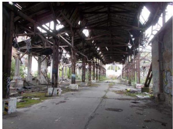
Abb. 50: Industrie- und Gewerbebrache (ehem. Messingwerk) (25.08.23)
