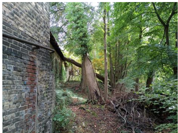
Abb. 41: Schmalen Bereich zwischen Bebauung (links) und Böschung zum Mühlengraben (rechts) 30.08.23)
