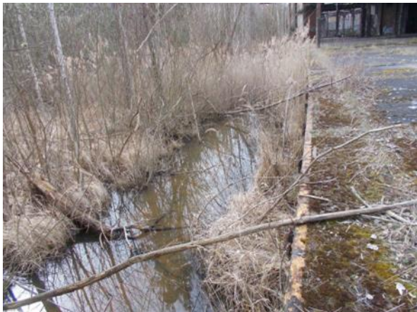
Abb. 32: Stauwasser im ehemaligen Gleisbett (30.03.23)
