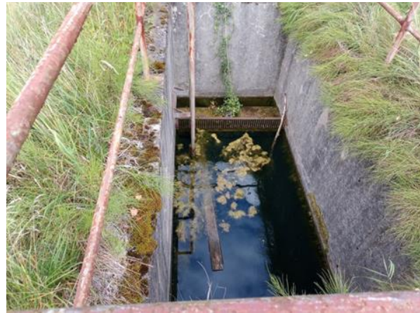
Abb. 27: Eines der beiden östlichen Becken (25.08.23)
