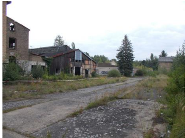
Abb. 48: Industrie- und Gewerbebrache (ehem. Messingwerk) (25.08.23)
