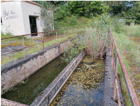
Abb. 26: Westliches Becken mit Pflanzenbewuchs (25.08.23)
