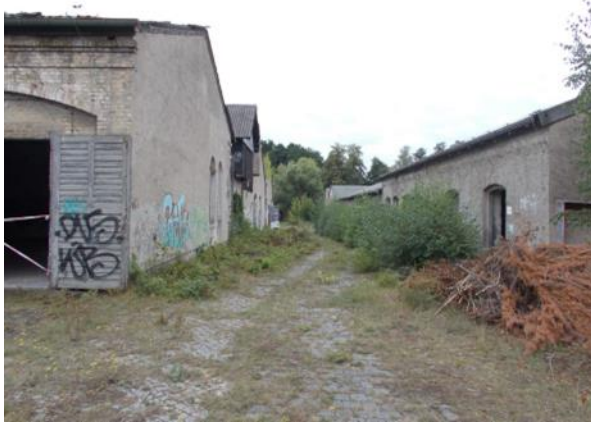
Abb. 49: Industrie- und Gewerbebrache (ehem. Messingwerk) (25.08.23)
