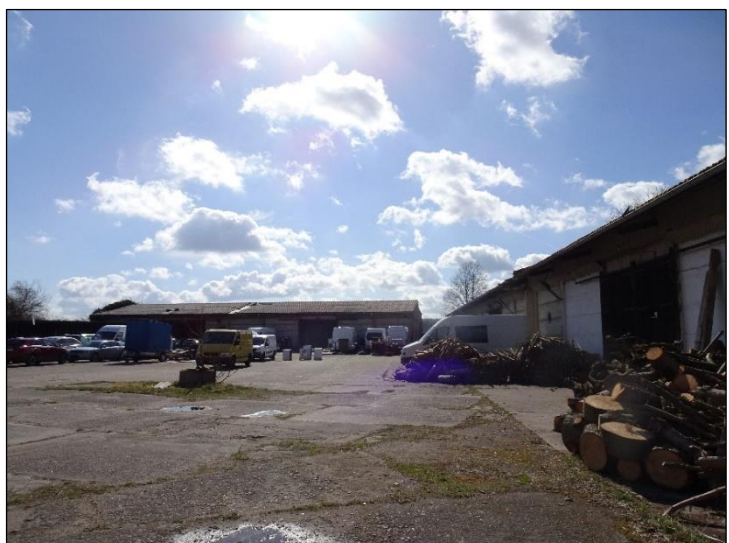
Abbildung 5: Grenzbebauung an der westlichen und südlichen Bearbei- tungsgrenze
